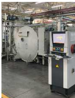
Печь после выполнения работ
