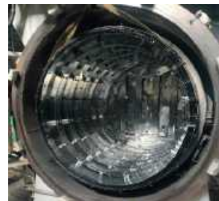
Печь после выполнения работ
